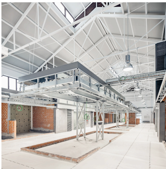
VISTA INTERIOR PROCÉS D'OBRES. MUNTATGE PARADES
